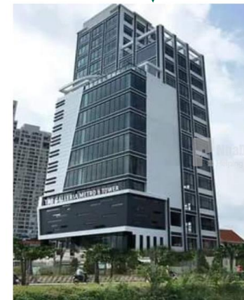
Galleria Metro 6 – Thảo Điền Quận 2
